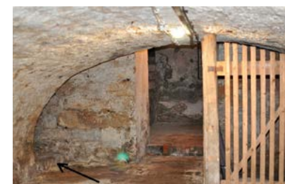
Gewölbe, gekennzeichnet ehemaliger Kellerausgang
